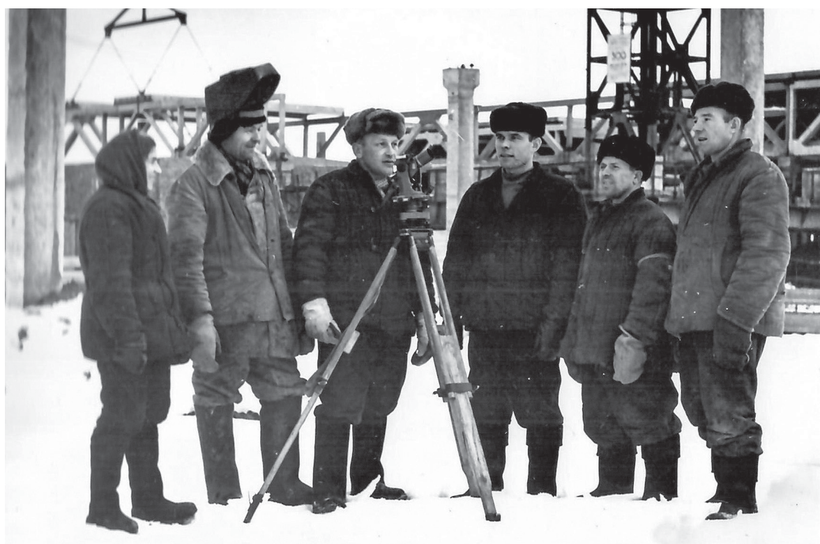
«Воткинскгэсстрой» в действии: комплексная бригада М. П. Недбайло приступила к монтажу фундаментов из сборного железобетона для прядильно-ткацкой фабрики № 2 КШТ.
