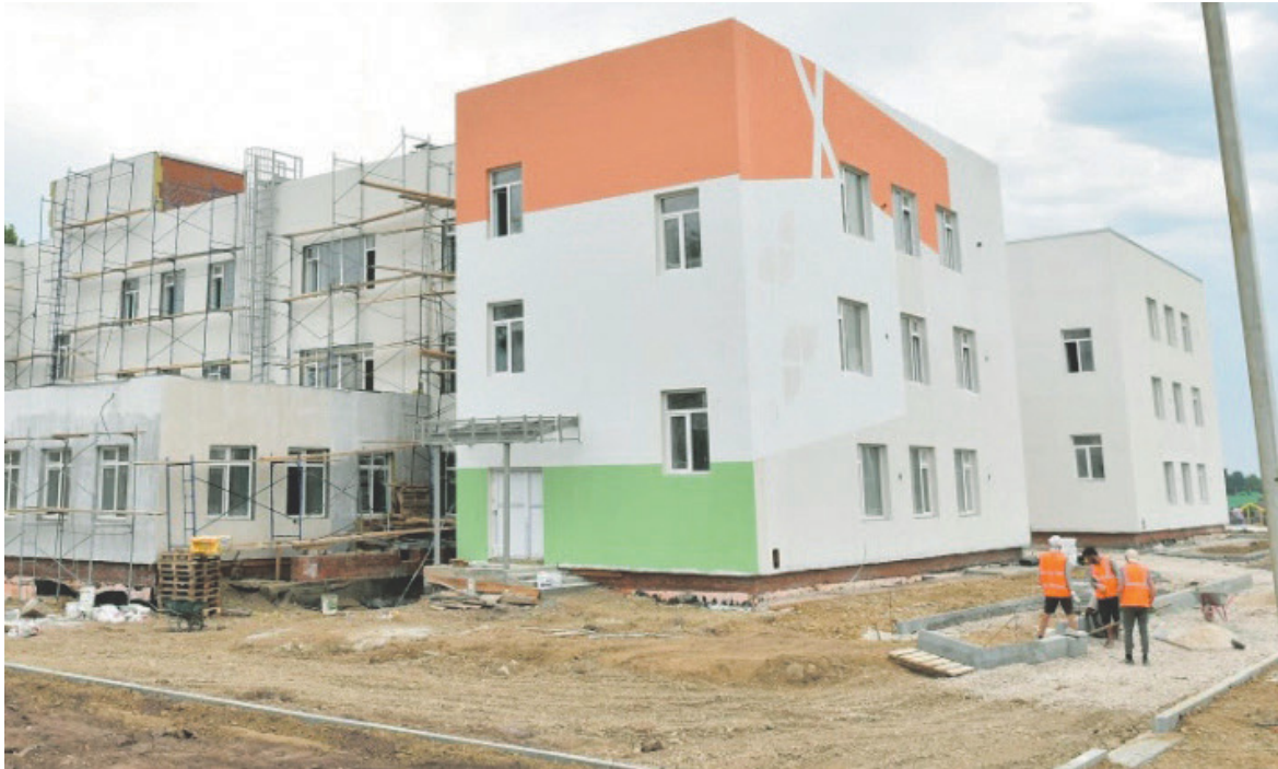
Строительство детского сада в Лысьве.
